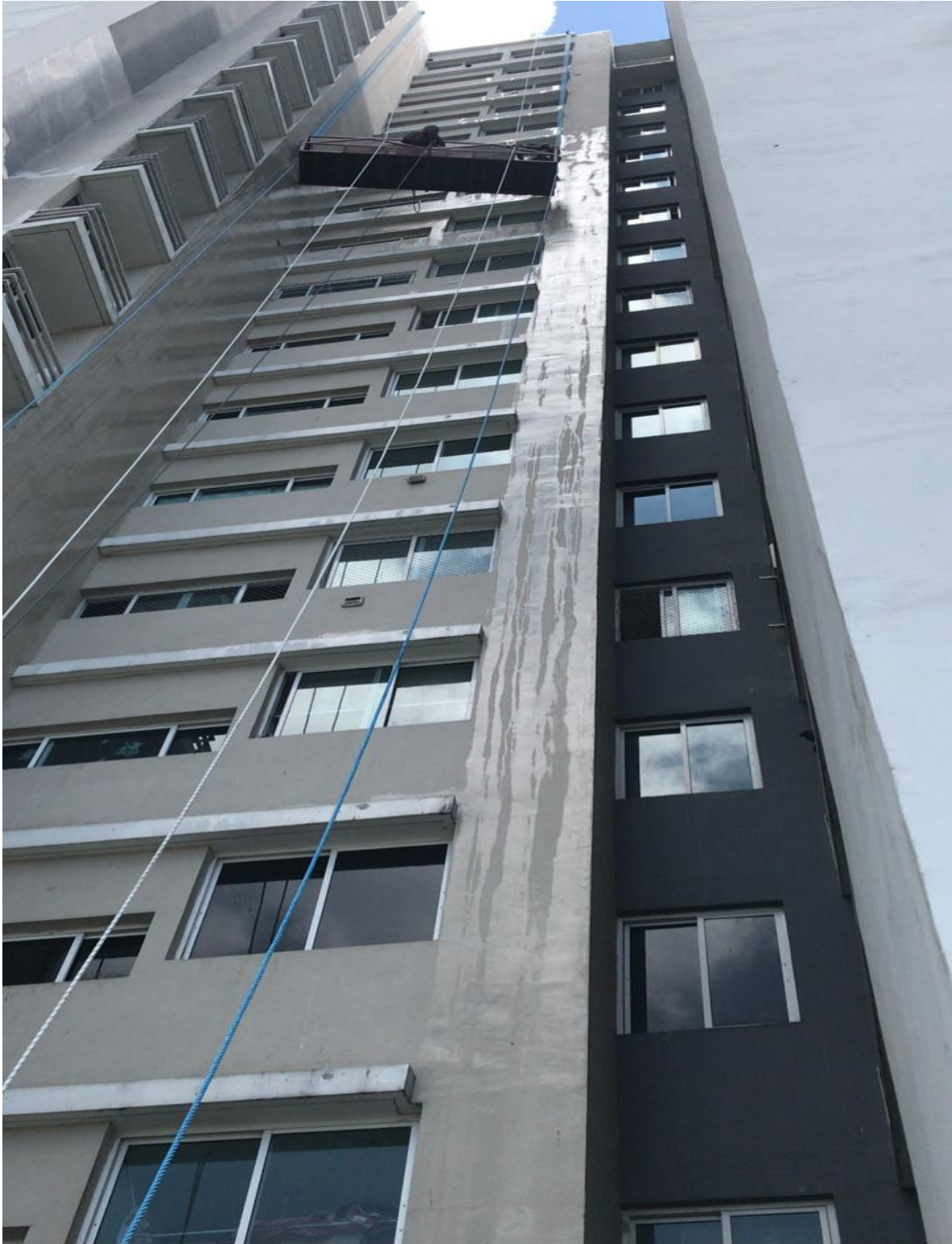
LAVADO DEL EDIFICIO
