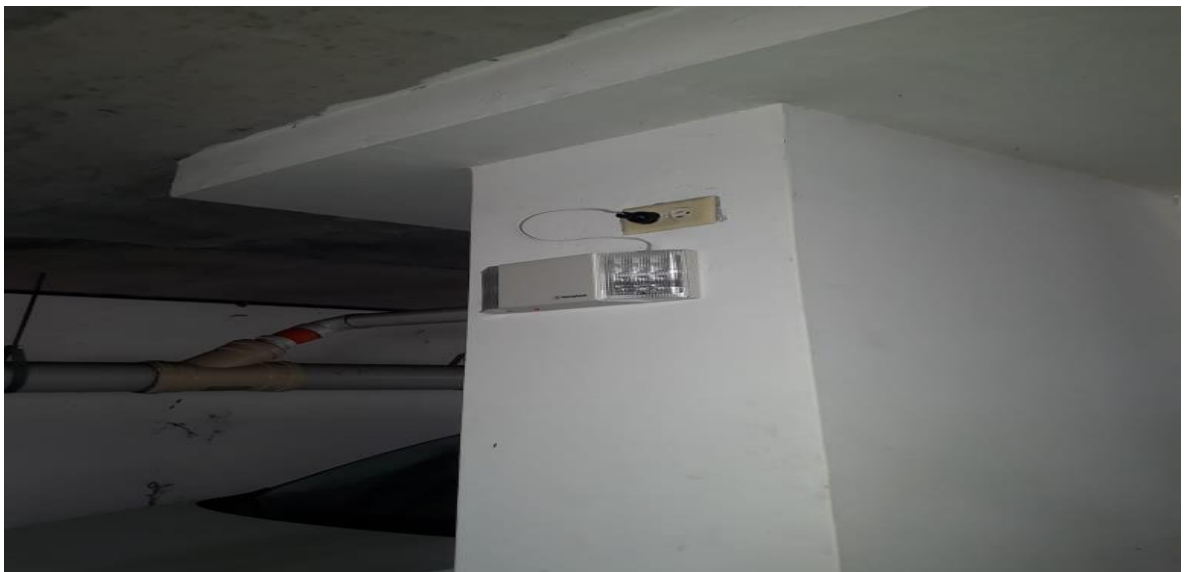
POSTURA DE LUCES DE EMERGENCIA DAÑADAS EN ESTACIONAMIENTO Y EN EL EDIFICIO
