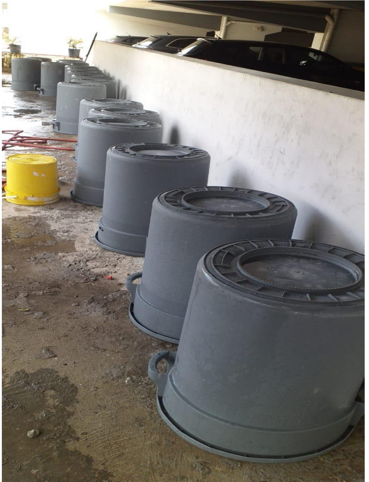
Limpieza profunda de tinacos de los pisos
