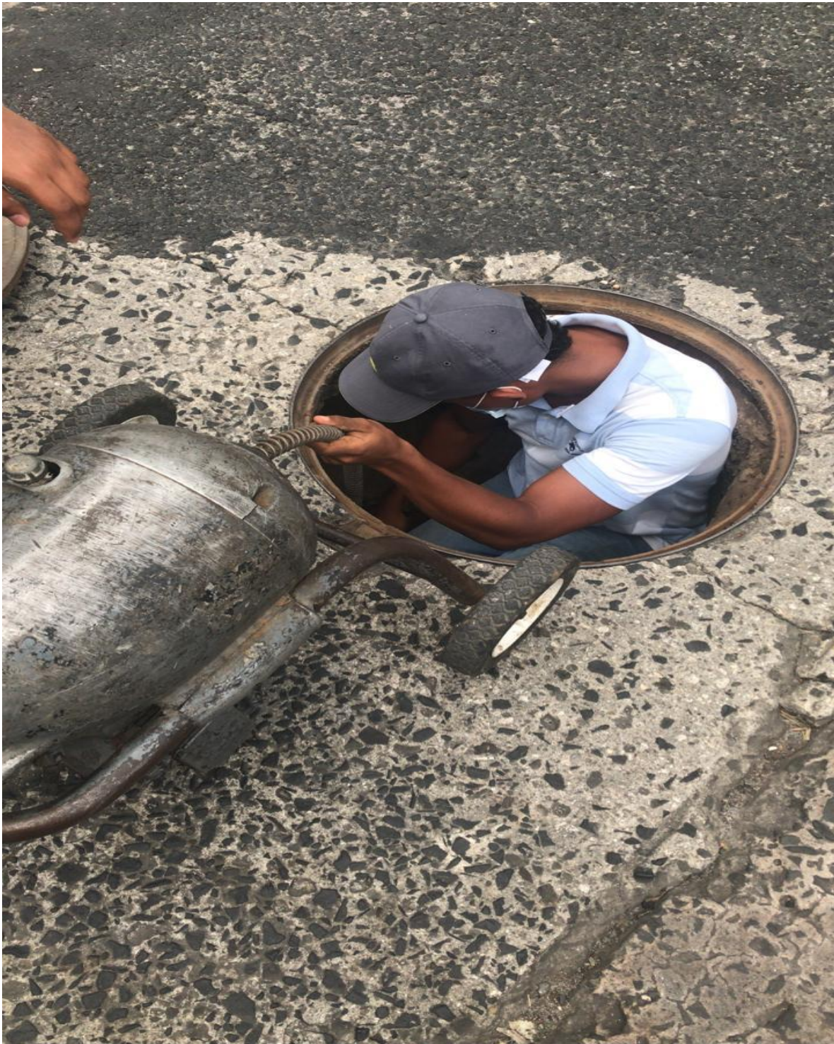
DESTAPE DE CAÑERÍA DE AGUAS NEGRAS ESTACIONAMIENTO DE VISITAS
