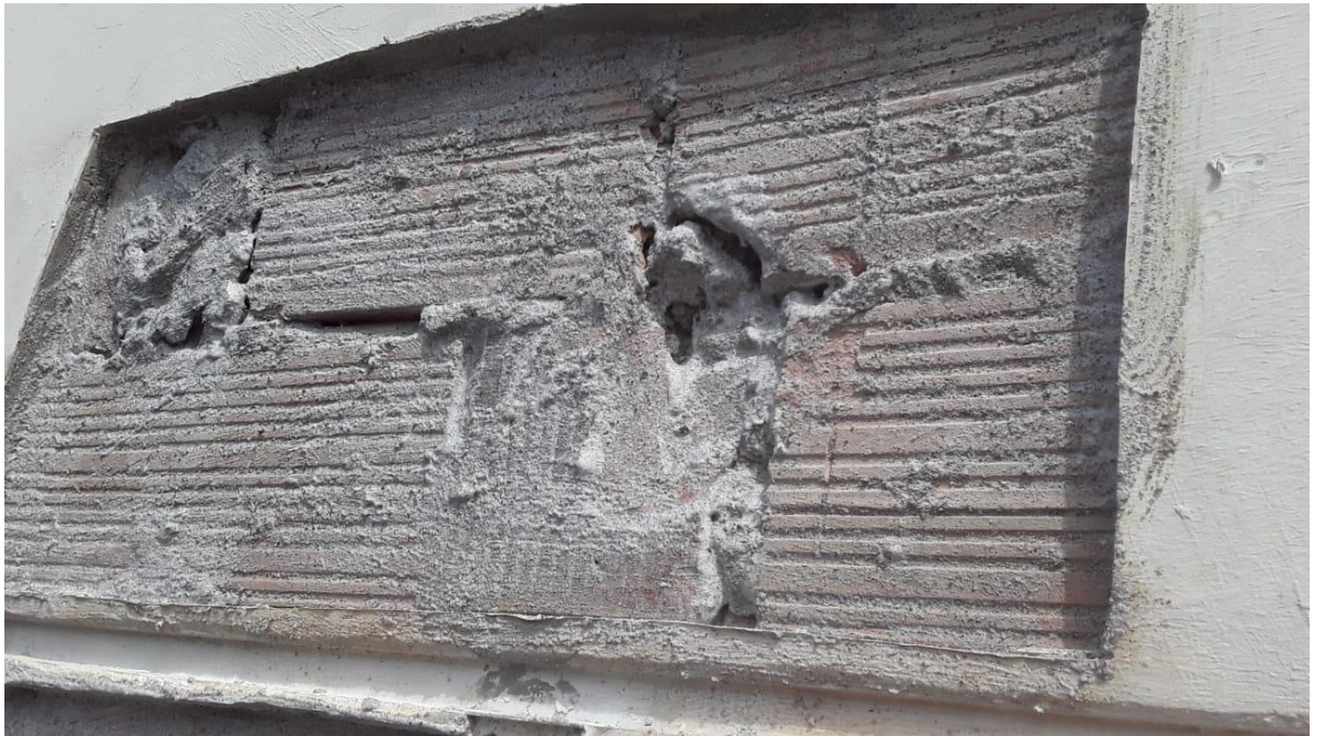
REPARACION DE REPELLOS FLOJOS TRANSMISORES DE LLUVIA HACIA EL INTERIOR DE LOS APARTAMENTOS
