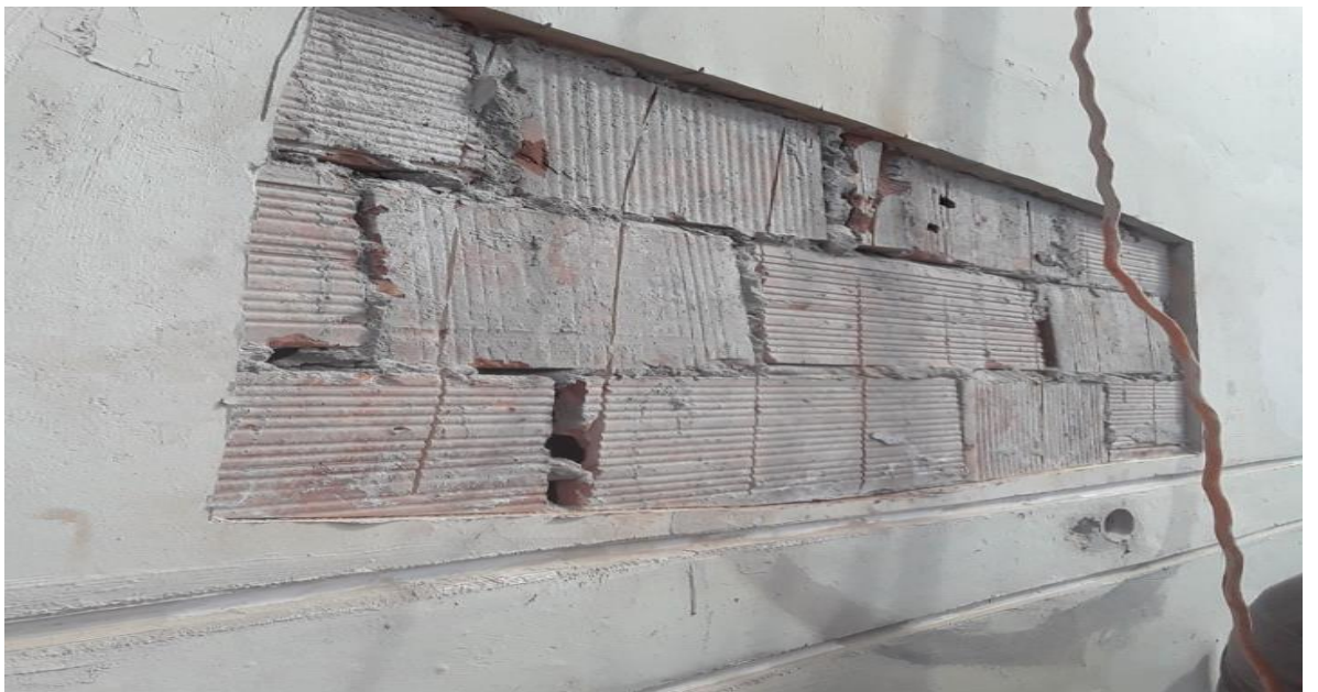
REPARACION DE REPELLOS FLOJOS TRANSMISORES DE LLUVIA HACIA EL INTERIOR DE LOS APARTAMENTOS
