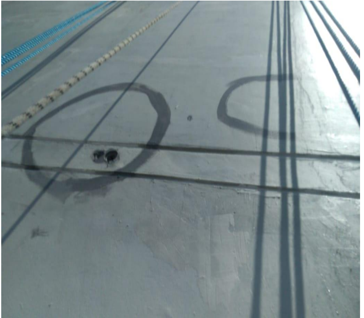
Inspección y señalización de repellos flojos para ser reparados antes de proceder con la pintura del edificio
