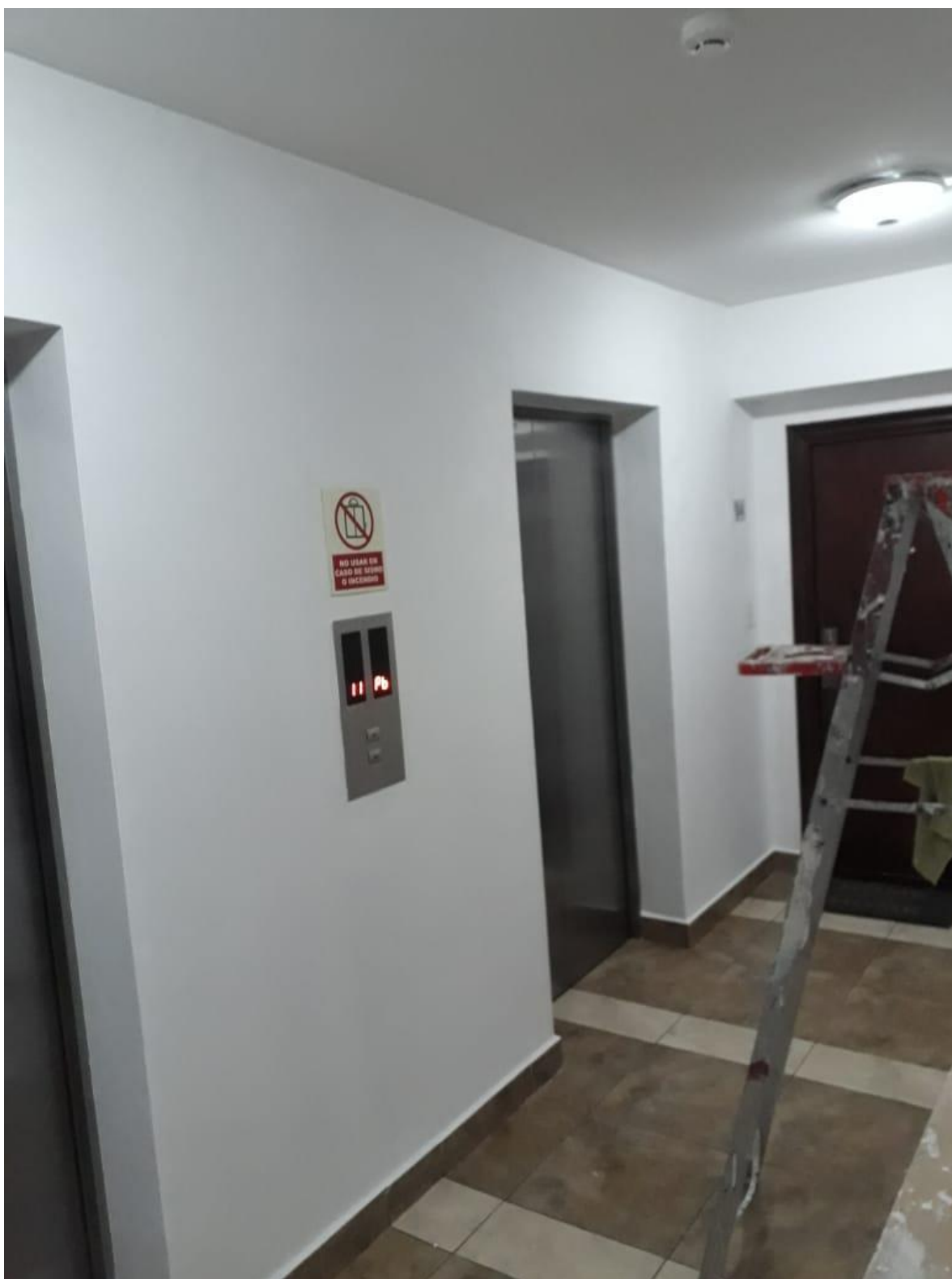
PINTADO DE LOBBIES DE PISO 9 DE LA TORRE 2
