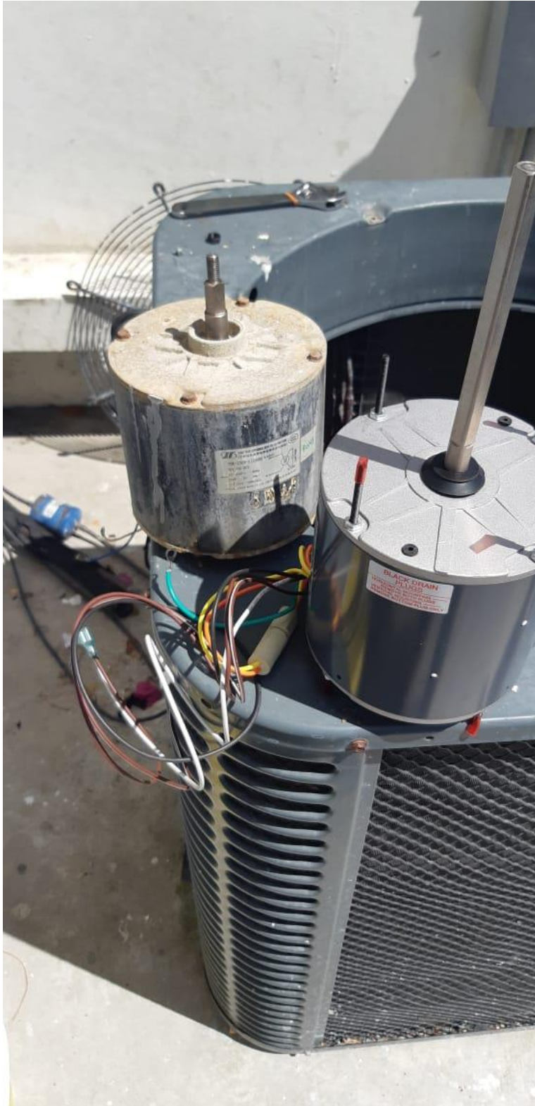
Cambio de motor de aire acondicionado salon de eventos t1
