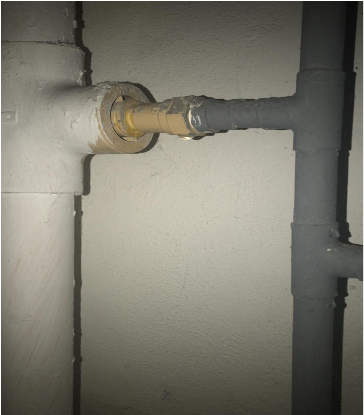
Arreglo de tubería fisurada en torre 2
