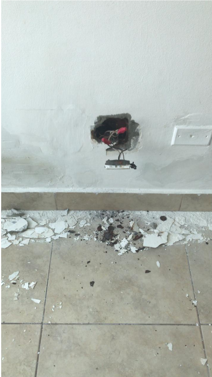
Reparación de apartamento 4D por filtraciones externas
