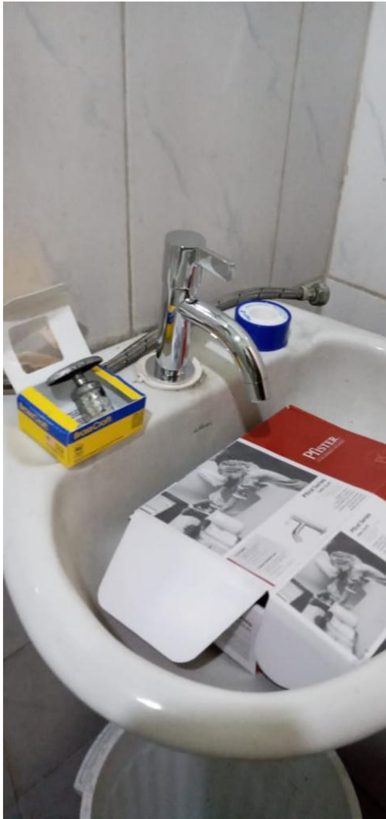
Reparaciones de baños del área social
