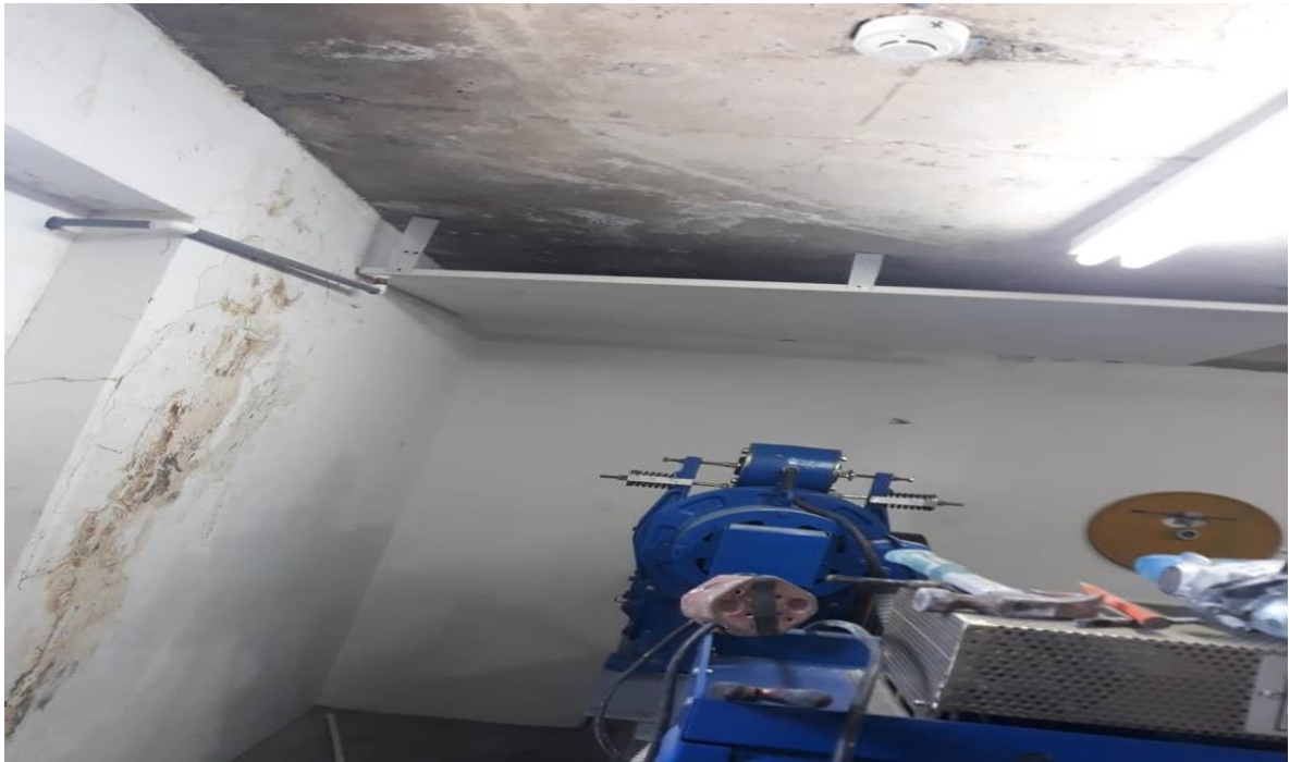
Montura de bandejas para proteger máquinas de elevadores torre 1 de la filtración detectada en el tanque
