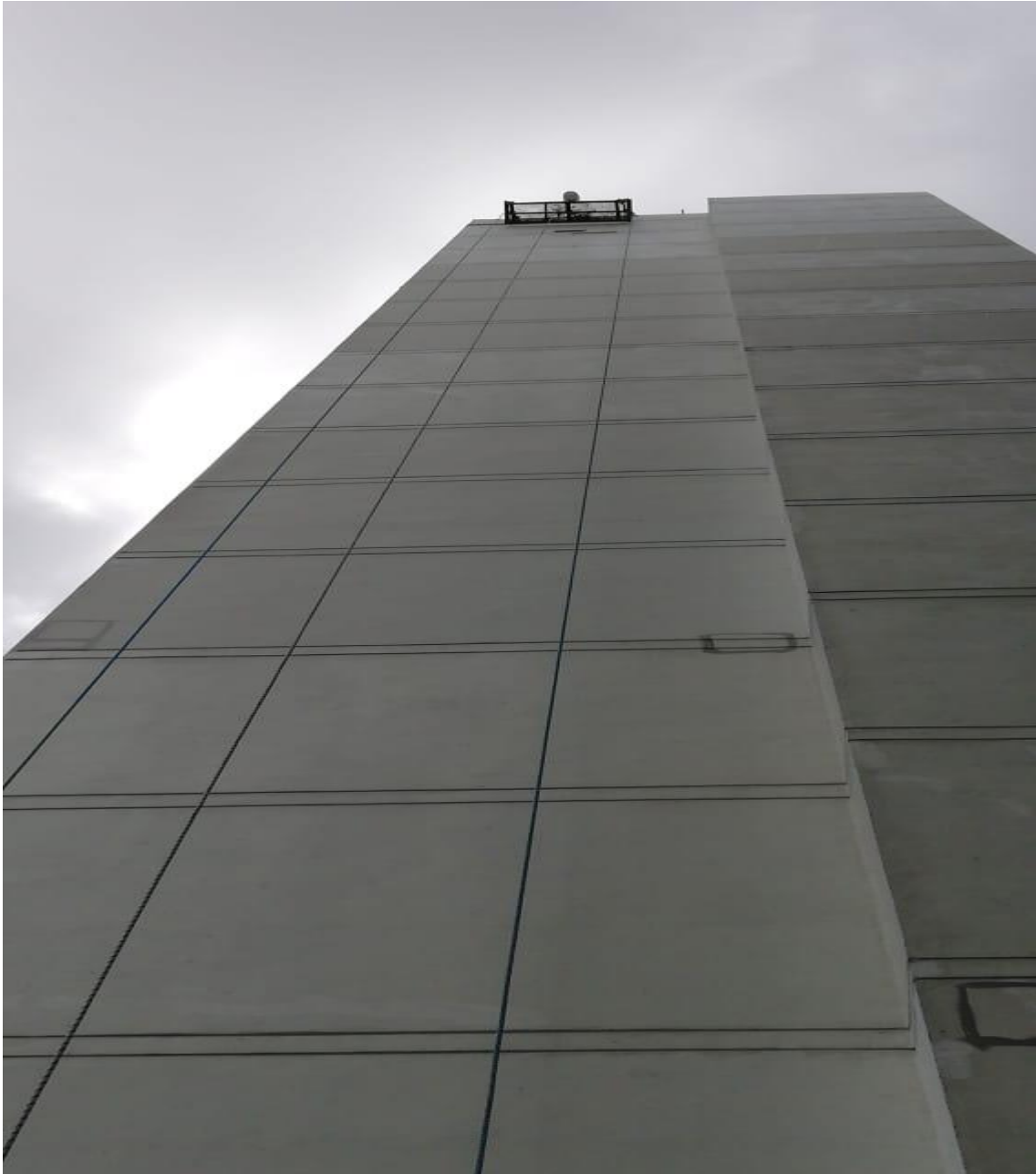
Continúa la reparación de áreas externas en la torre 1
