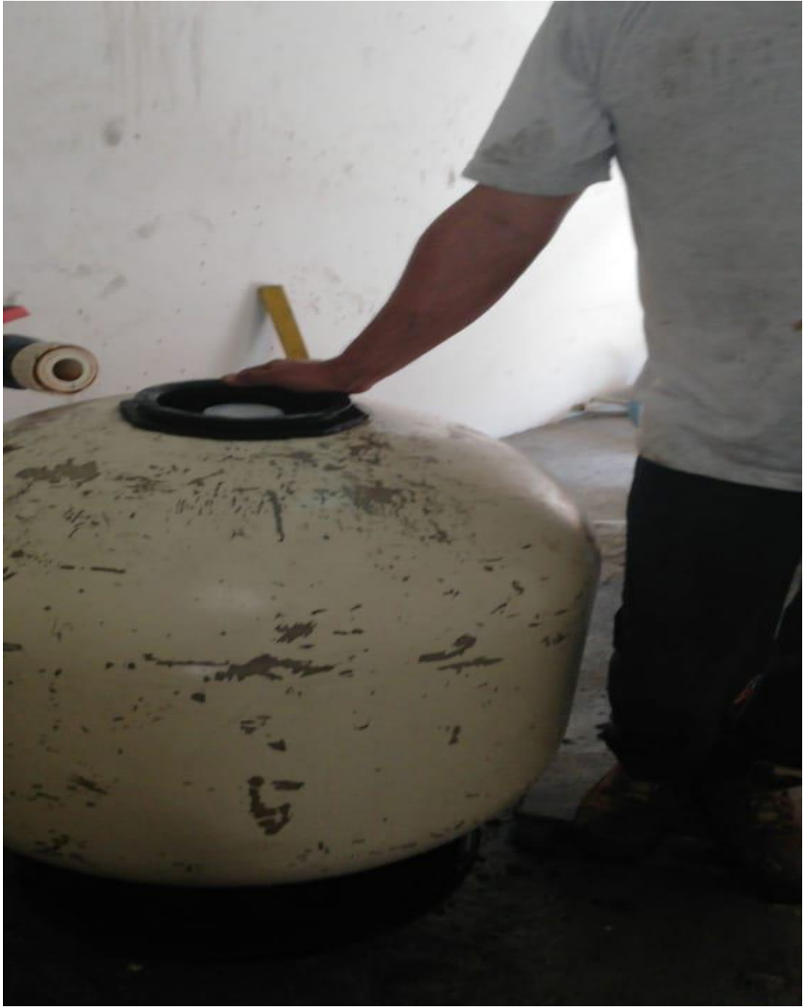
Cambio de la arena al filtro de la piscina
