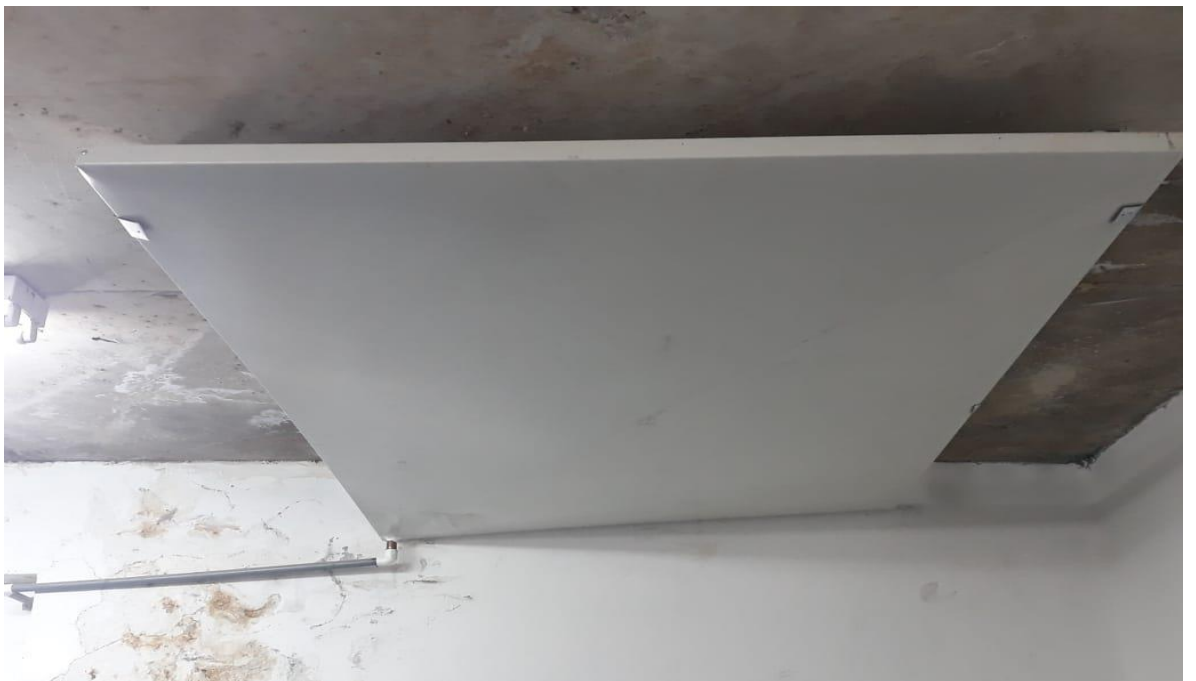
Montura de bandejas para proteger máquinas de elevadores torre 1 de la filtración detectada en el tanque
