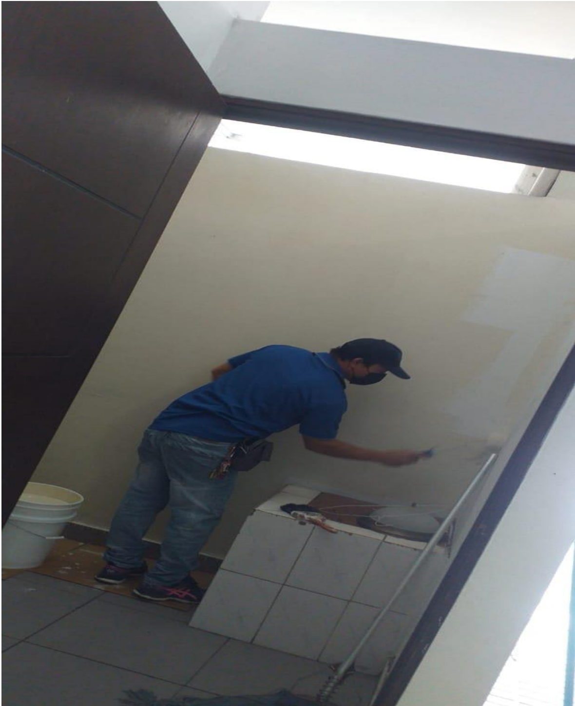
PINTADO DE COLABORADORES TORRE 2
