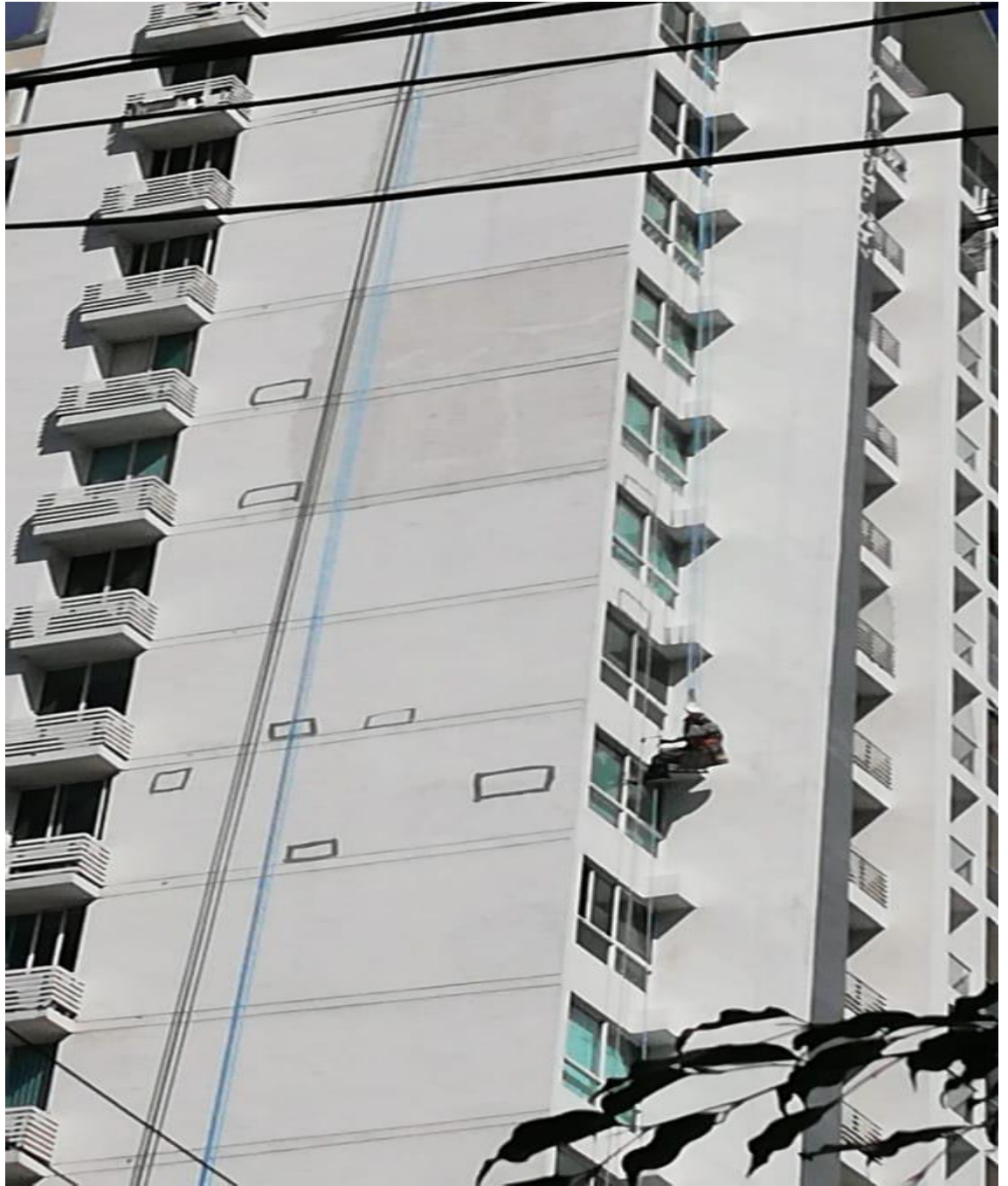
Inspección y señalización de repellos flojos para ser reparados antes de proceder con la pintura del edificio ala de apartamentos C TORRE 1
