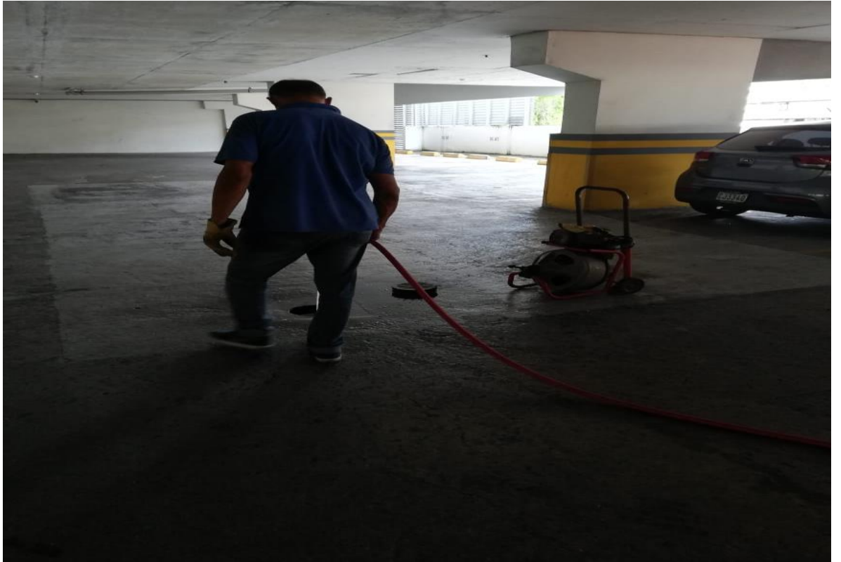
DETAPE DE DESAGUES ESTACIONAMIENTO DE LEDIFICIO
