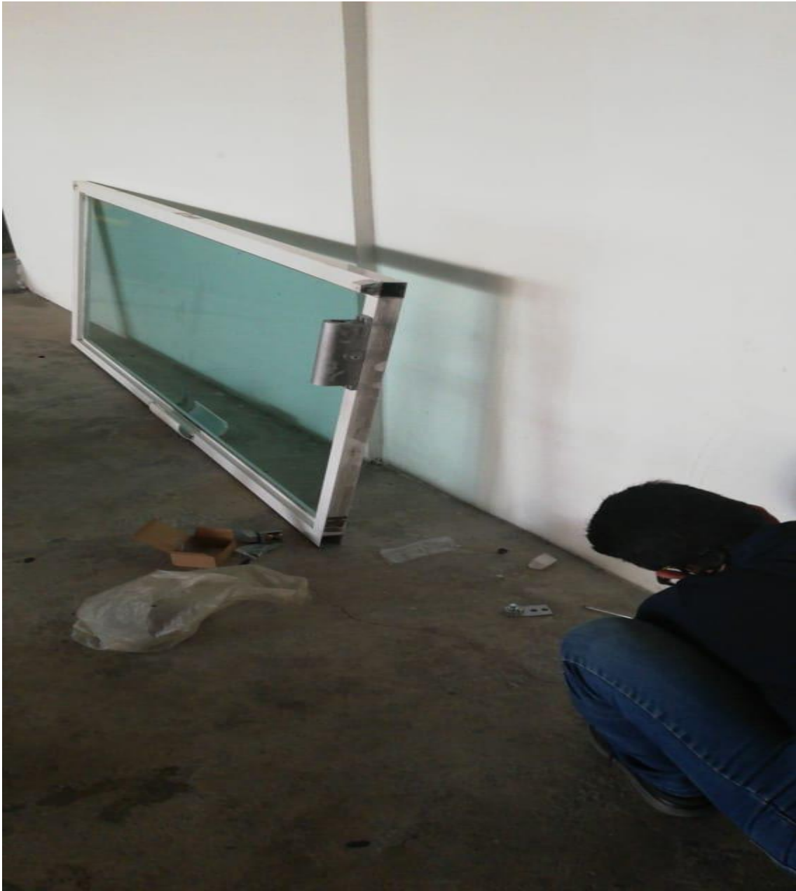
Desprendimiento y arreglo de puerta del E1 de la torre 1
