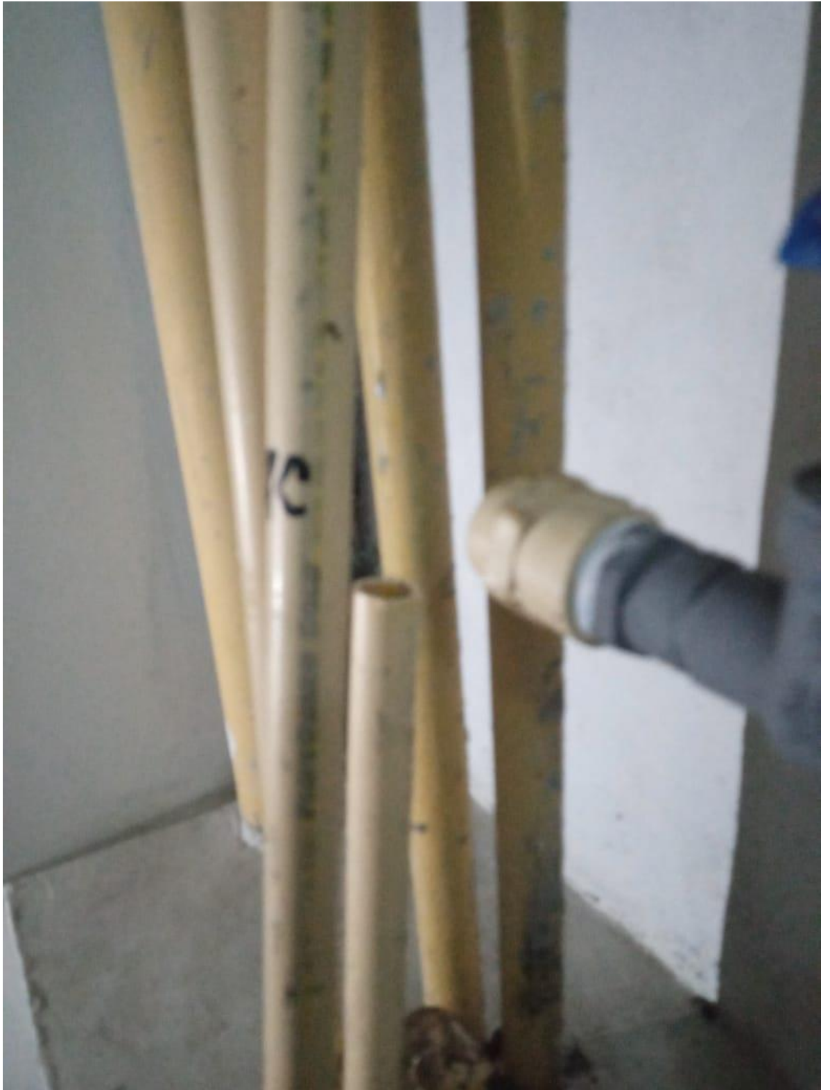
Arreglo de tuberías fisuradas en el pisos 7 de la torre 1
