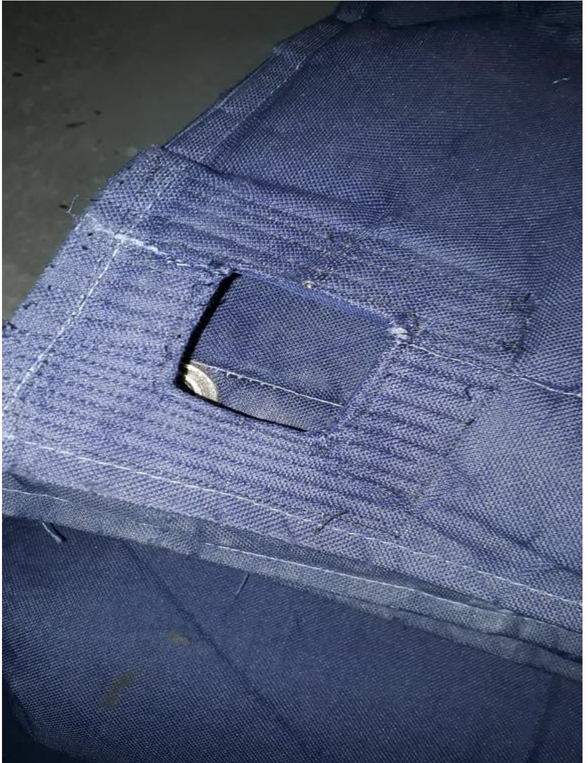
Arreglo de lonas protectoras elevadores de la torre 2
