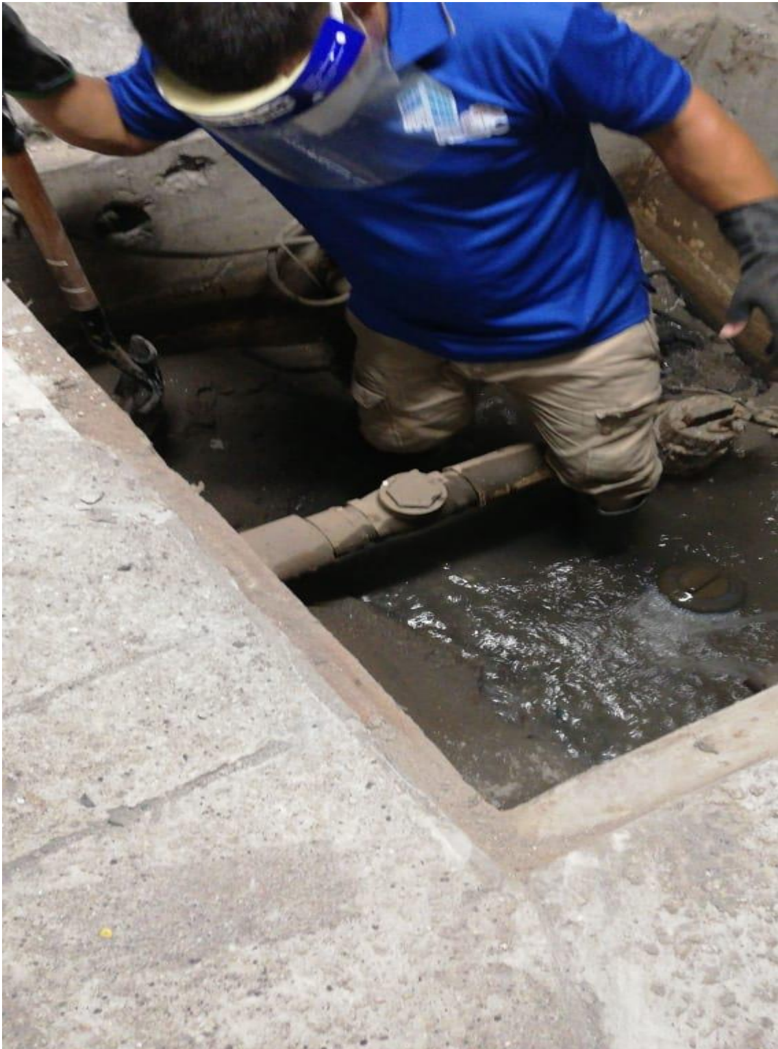
Limpieza y descongestionamiento de arenas en tanquillas de paso de agua del edificio
