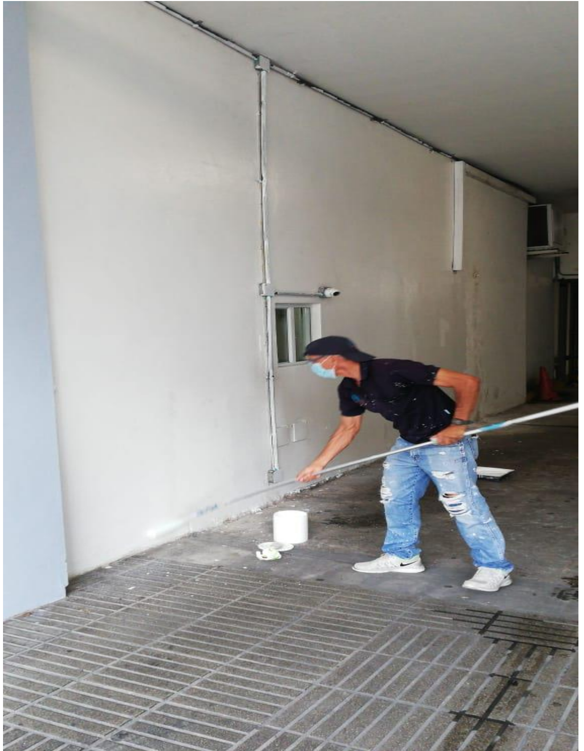
Se pintó fachada de entrada estacionamiento de visitas torre 2
