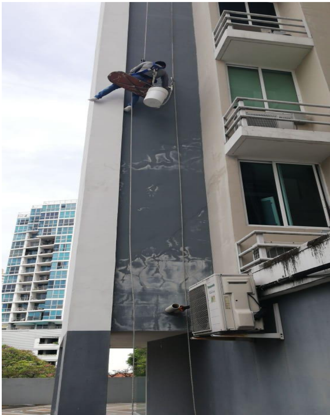
Arreglo de fachada externa de 10 apartamentos con grietas
