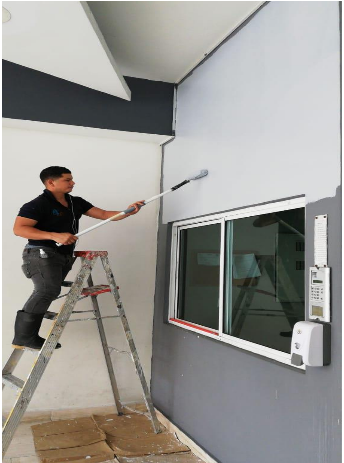
pintado del frente de fachada de lobbies ambas torres
