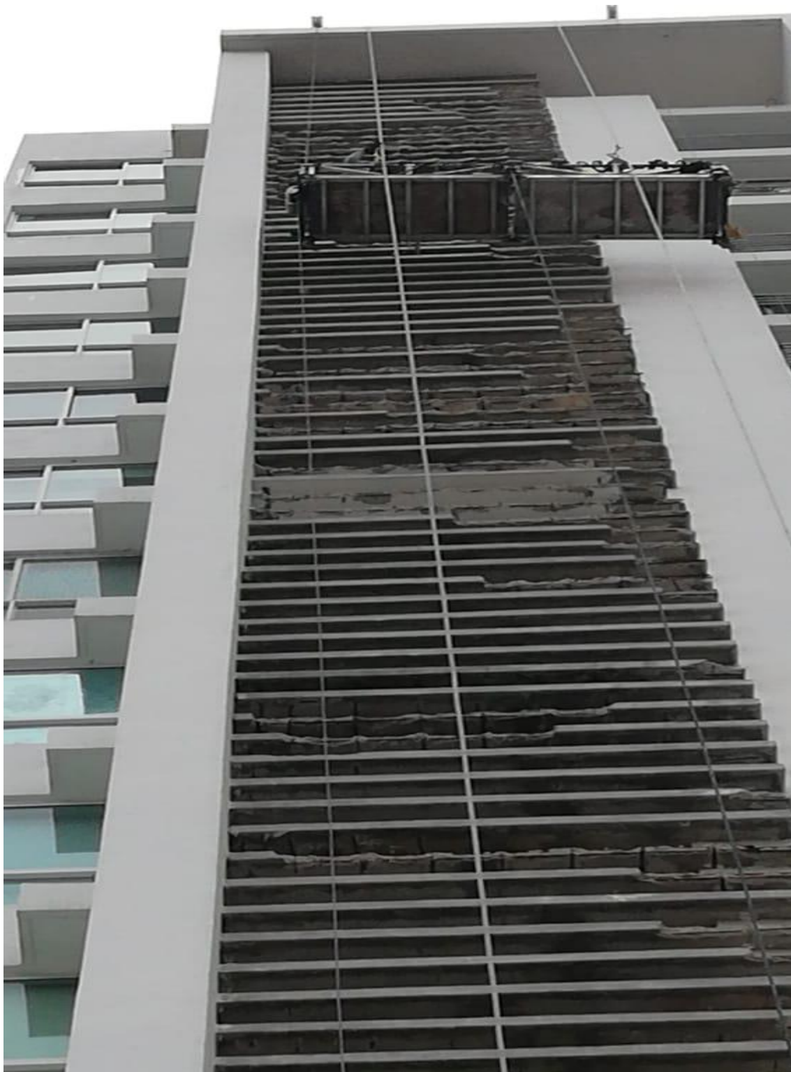
Comienzo de reparación de parasoles torre 2
