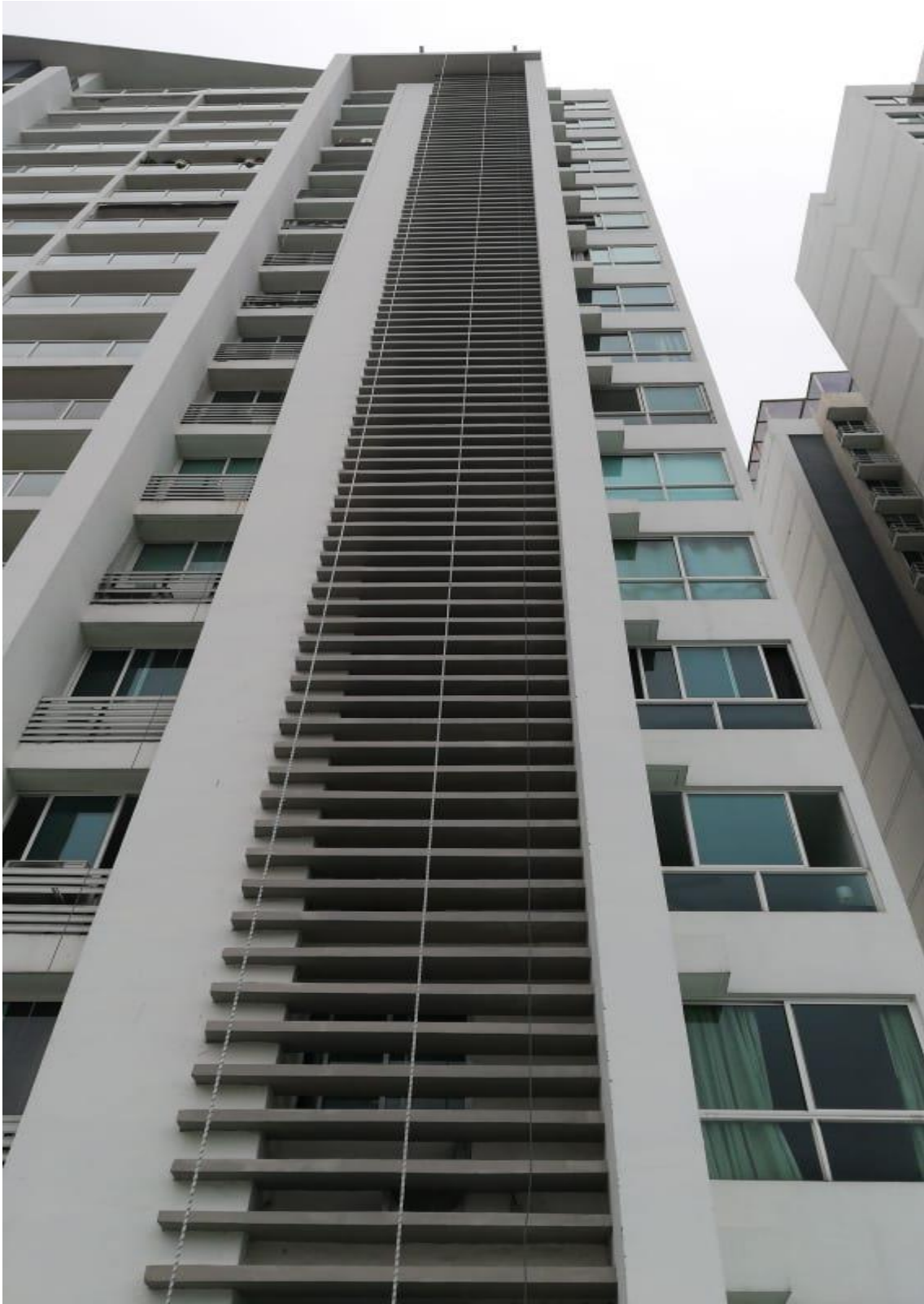
CONCLUSION DE ARREGLO DE LOS PARASOLES EN TORRE 1
