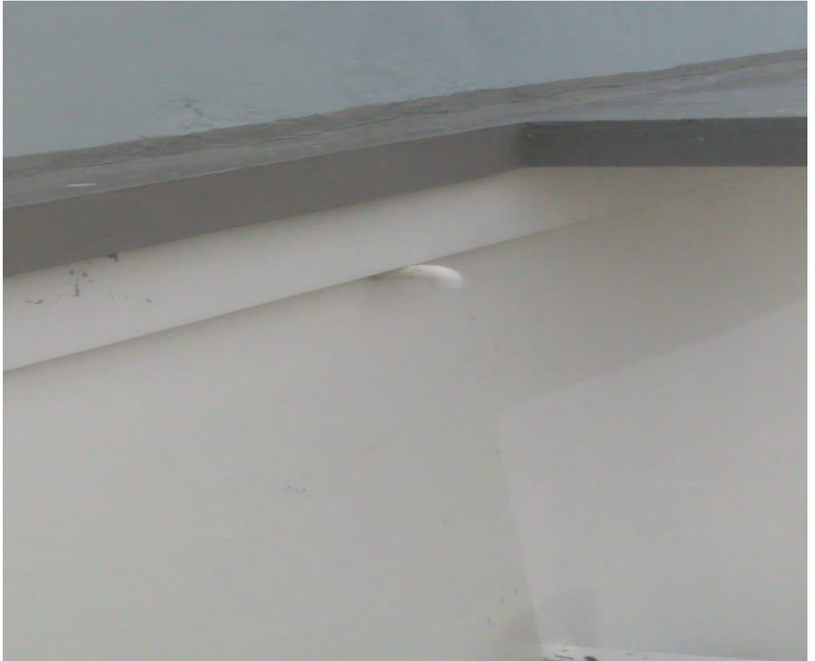
Arreglos en fachada externa
