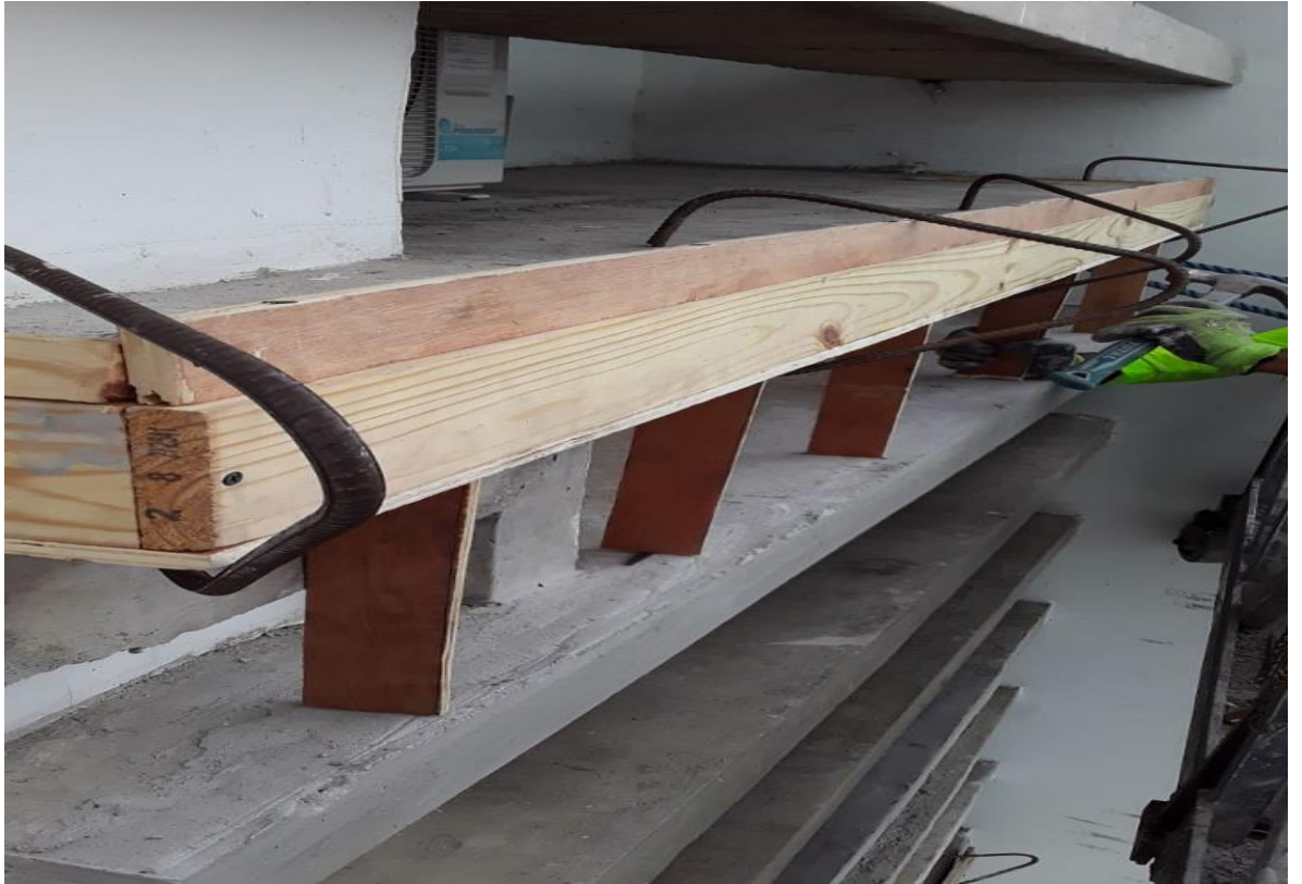
Se comenzó con el arreglo de los parasoles de ambas torres
