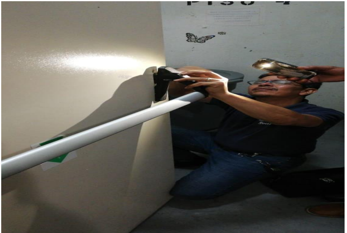
Arreglo de cerraduras de puertas de escaleras de emergencias
