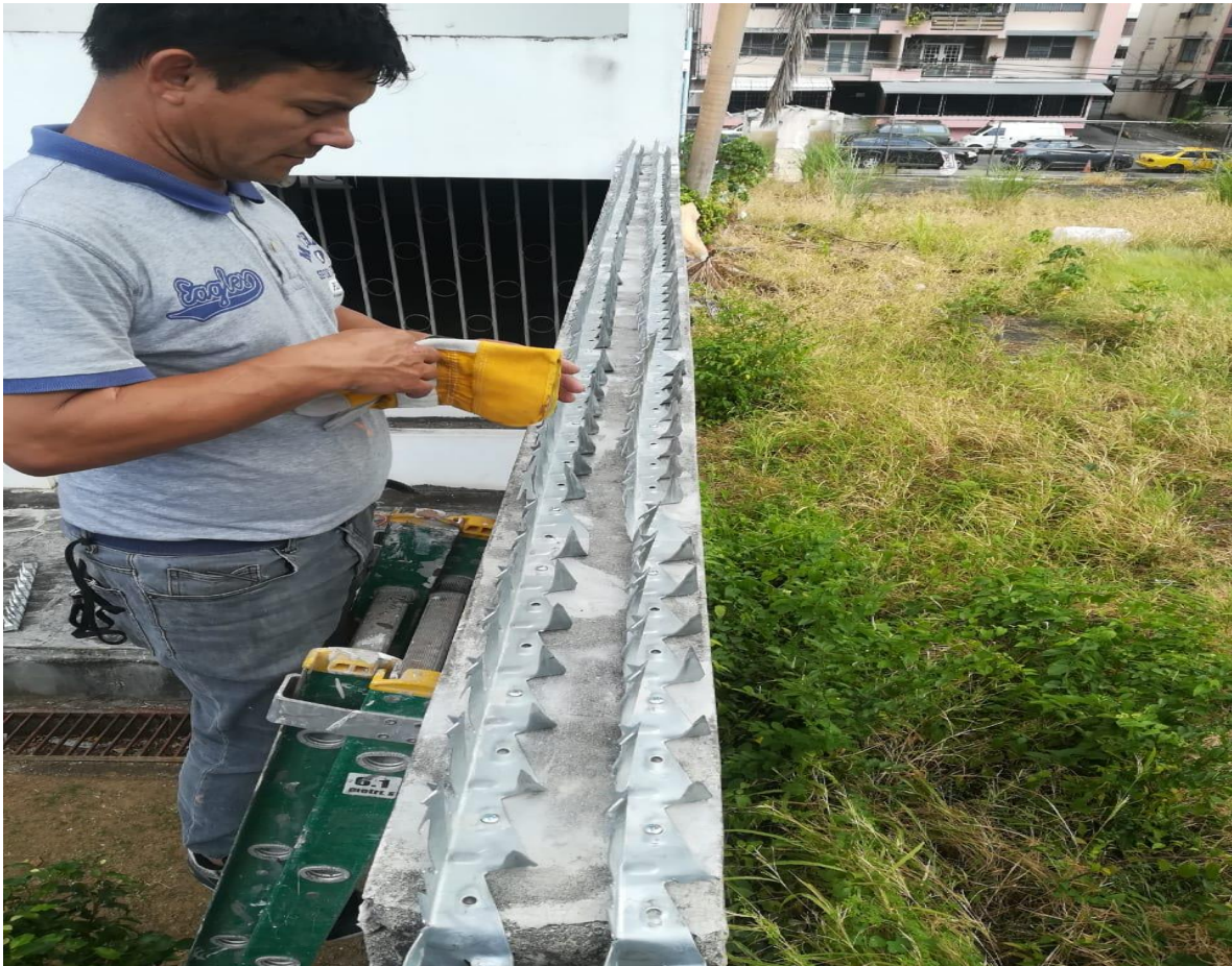
COLOCACION DE PUAS PAREDES PERIMETRALES QUE DAN CON EL PARQUE
